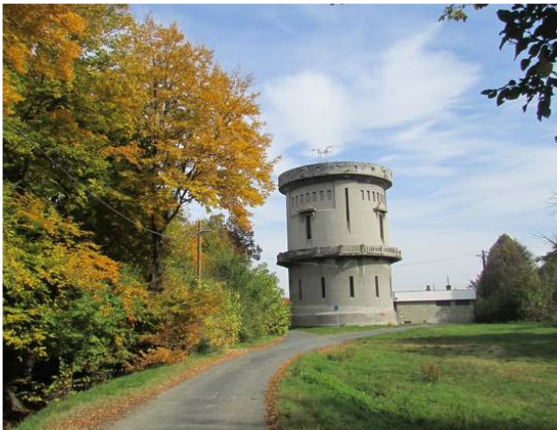
Tetején áll a város első – 1898-ban épült – víztornya.
