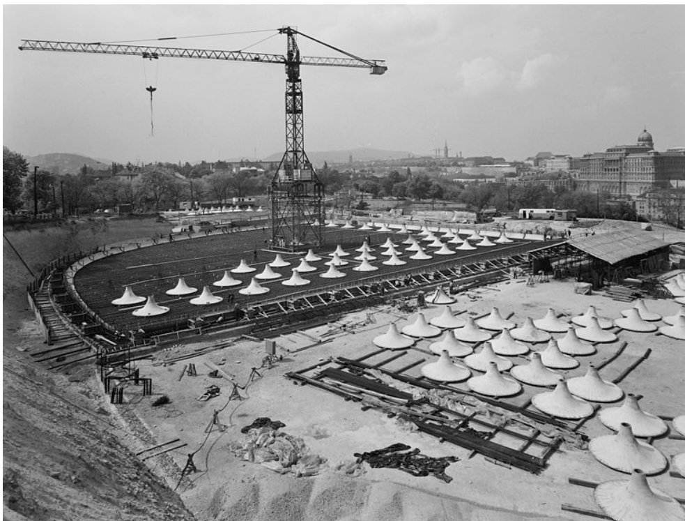
A medencerendszer építése 1977-ben
